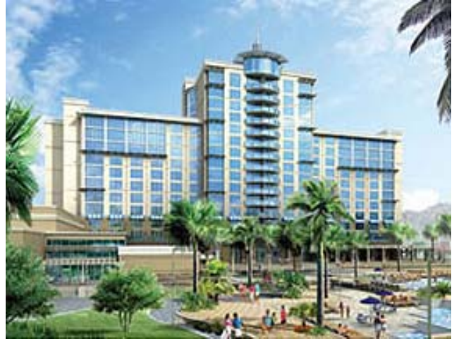
AGUA CALIENTE CASINO, PALM SPRINGS, USA
